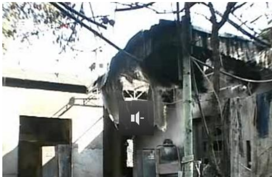
Incêndio urbano na freguesia de Perre, Viana do Castelo (2007/11/18). Fonte: RTP
