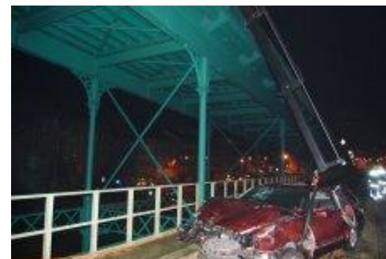
Despiste de automóvel para o tabuleiro ferroviário da ponte Eiffel, em Viana do Castelo. Fonte: Correio do Minho (2010/12/19).
